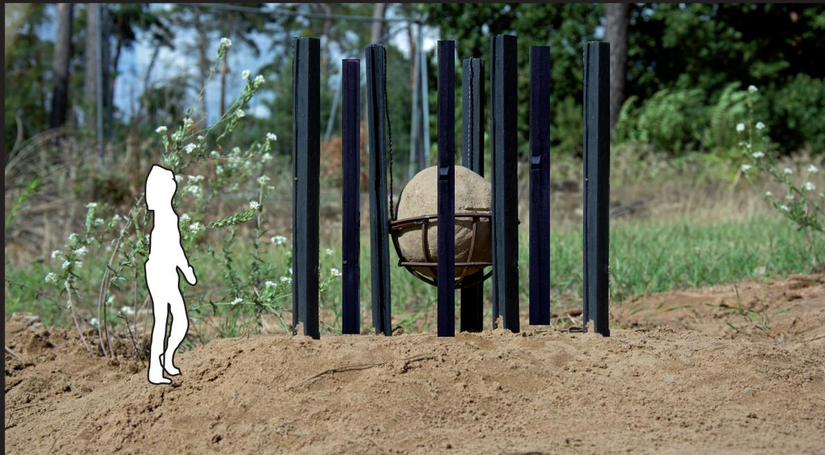
Die Stahlträger werden einen Meter tief im Erdboden vergraben und in ein Fundament eingebettet. Die alleinstehenden H-Träger bekommen jeweils einzelne Schotter Fundamente. Die 3 Stehlen die die Kugel tragen bekommen ein gemeinsames Fundament und werden mit einem Korb verbunden. Auch hierfür wird ein H-Träger wiederverwendet.
